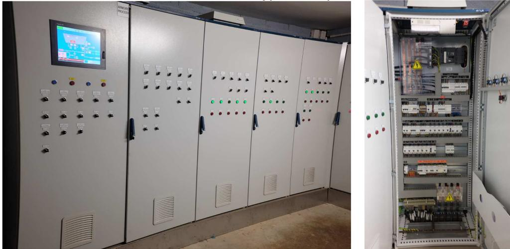
Les parafoudres de type II en place seront remplacés directement par du type I+II ou coordonnés à des nouveaux parafoudres de type I (coordonnés en cas de marque similaire).
